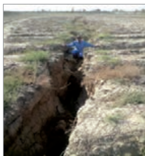
ب) ترک و شکاف
