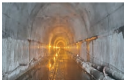
الف) پوشش‌های بتنی در مغارها
