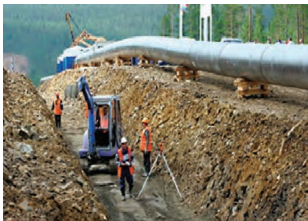
عملیات احداث خط لوله گاز آلتایی به طول ۳۰۰۰ کیلومتر که گاز سیبری روسیه را به چین منتقل می کند. این عملیات در حال اتمام است.
