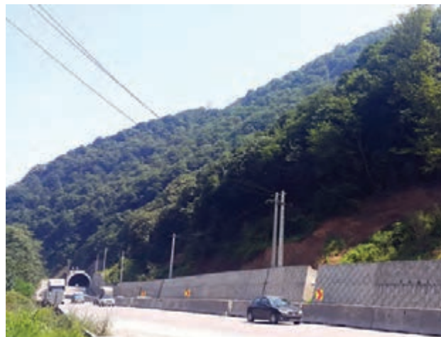
نصب حفاظ بتونی - جاده قائم‌شهر
